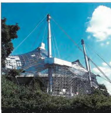
Einrüstung der Überdachung des Olympiageländes, München
