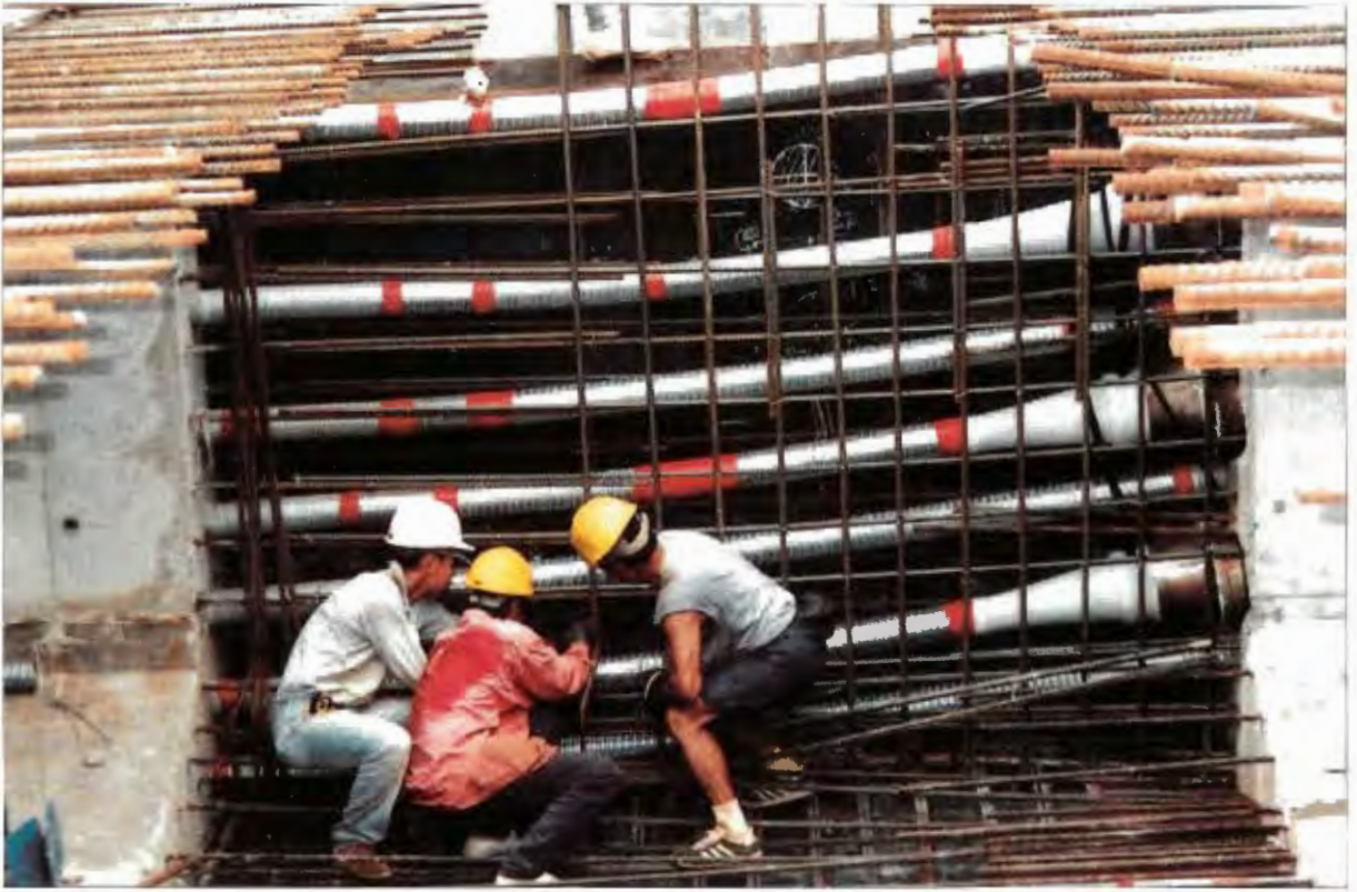
Kopplungsstücke eines Spannbetonträgers
