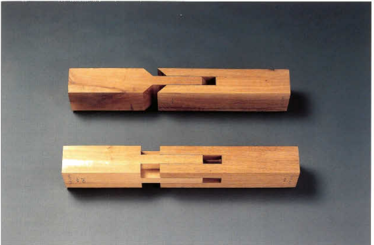
Zapfen über Kreuz und schräg eingeschnittener Scherzapfen mit Grat
