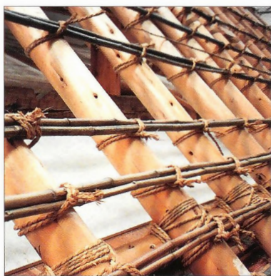
Abb. 2 Befestigung von Rafen und Latten mit Strohschnüren
