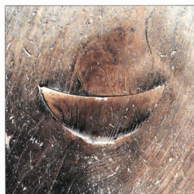
Abb. 7 Ausfüllung einer Fehlstelle an einer Diele
