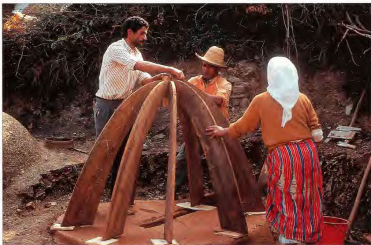
Aufbau eines neuen Gasbrandofens mit einer Holzkonstruktion zum Bau der Kuppel
